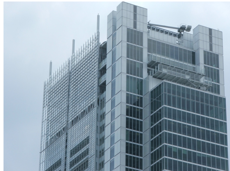
Edificio oficinas Intesa Sanpaolo, Renzo Piano, Torino
