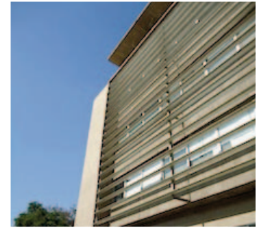
Figura 5.50. Protecciones solares, Edificio Secretaría Regional Ministerial de Obras Públicas Atacama, Copiapó
