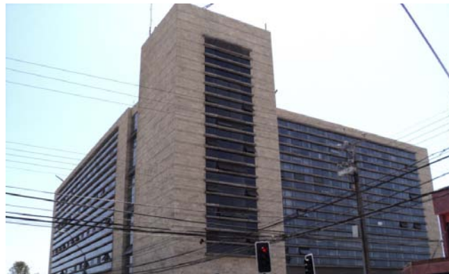
Figura 8.37. Edificio Secretaría Ministerial de Obras Públicas, Región de Antofagasta.
