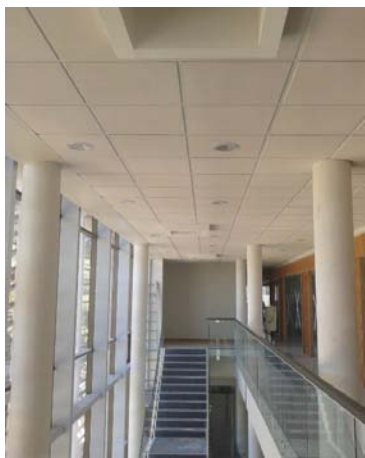
Figura 6.27. Acondicionamiento acústico en áreas comunes. Cielo absorbente.
