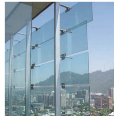
Figura 5.54. Protección solar a través de cristales con bajo factor solar. Edificio Duoc, Santiago.
