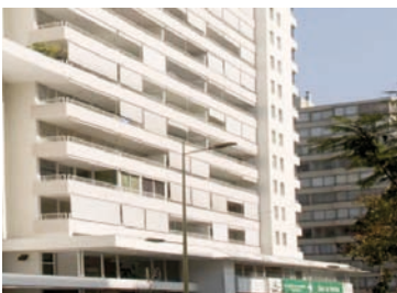
Figura 5.57. Toldos Exteriores Verticales, Edificio Carlos XII de los Arquitectos de la Oficina Rodrigo Larraín.
