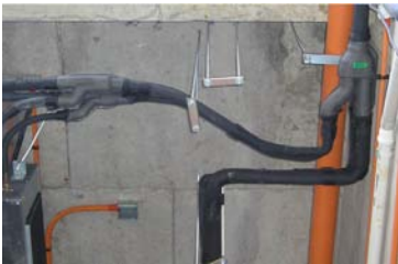
Figura 7.50. Branch derivador de flujo.
