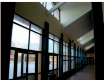
Figura 8.138: Vista interior pasillo
