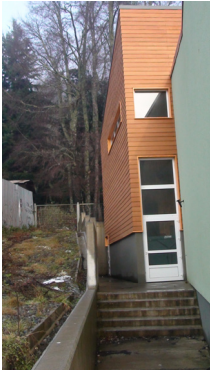
Figura 8.68. Acceso exterior internado
