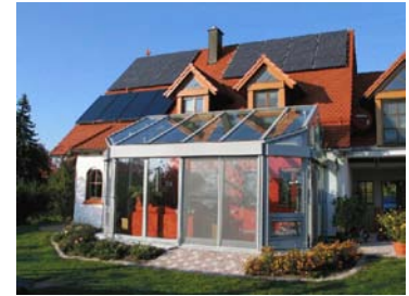
Figura 7.10. Instalación solar agua caliente y paneles fotovoltaicos.
