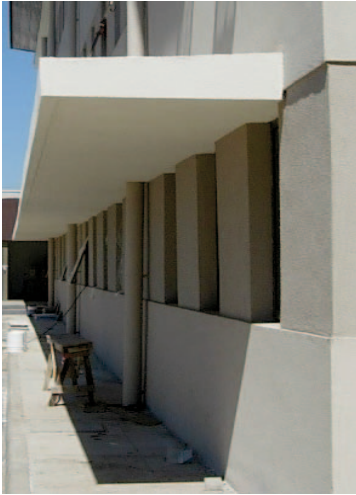
Figura 5.46. Alero horizontal, Contraloría de Temuco.
