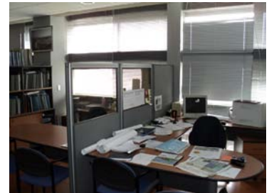
Figura 6.35. Puestos de trabajo en oficinas de planta abierta, se aprecia barrera acústica divisoria.
