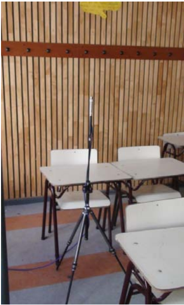
Figura 6.32. Panel absorbtor ranurado Escuela Francisco Valdés Subercaseaux, comuna de Curarrehue.
