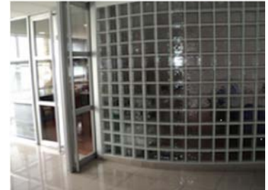
Figura 5.44. Tabiques translúcidos, Edificio Secretaría Regional Ministerial de Obras Públicas Antofagasta.
